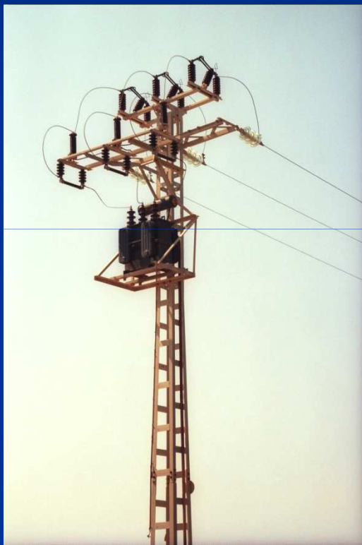
Seccionador y fusibles (cartucho)
