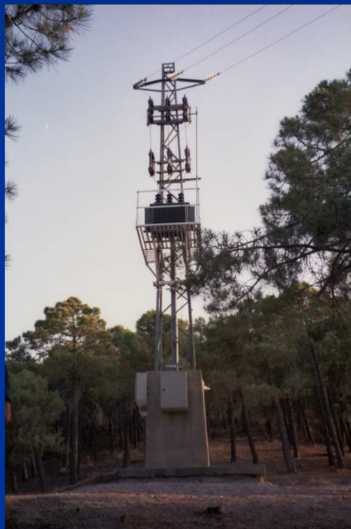
Seccionador y fusibles (cartucho)
