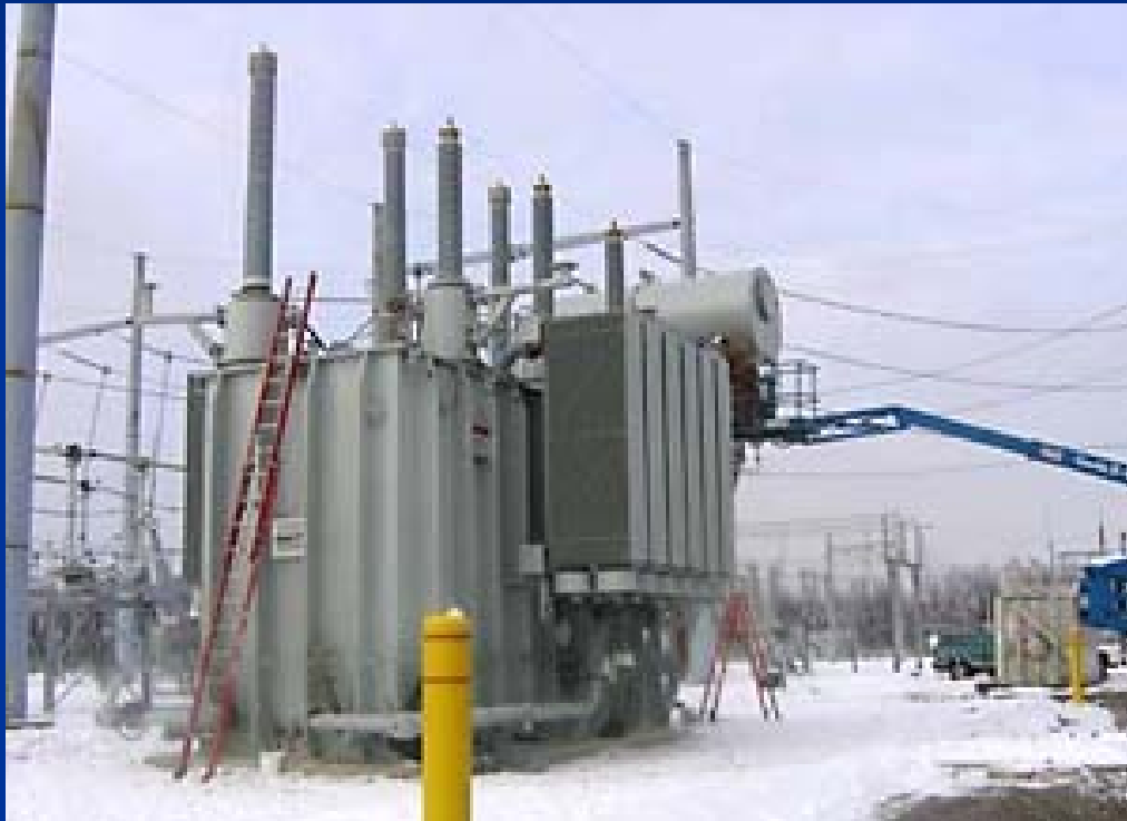
Autotransformador de 840 MVA y 230 kV
