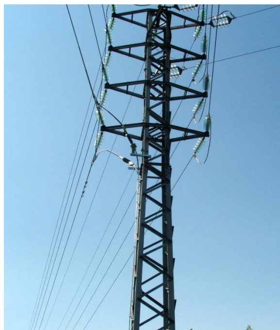
Figura A.256. Línea de MT con cable OPPC (conductor de fase – fibra óptica). Fuente: Prysmian.
