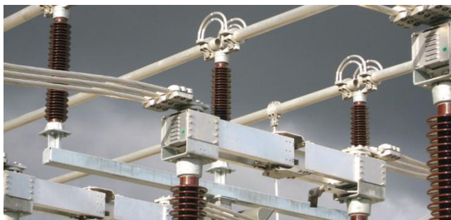
Figura A. 158. Contacto de dilatación. Fuente: Arruti.
