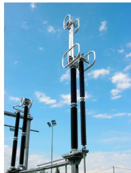
Figura A.159. Seccionador semipantógrafo Fuente: Alstom.
