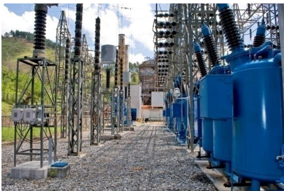
Figura A.138. Interruptores automáticos de gran volumen de aceite.
