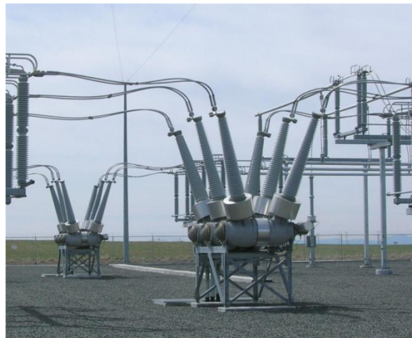
Figura A.135. Interruptores de tanque muerto.
