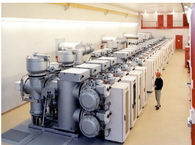
Figura A.190. Conductores de aluminio en una subestación eléctrica.
