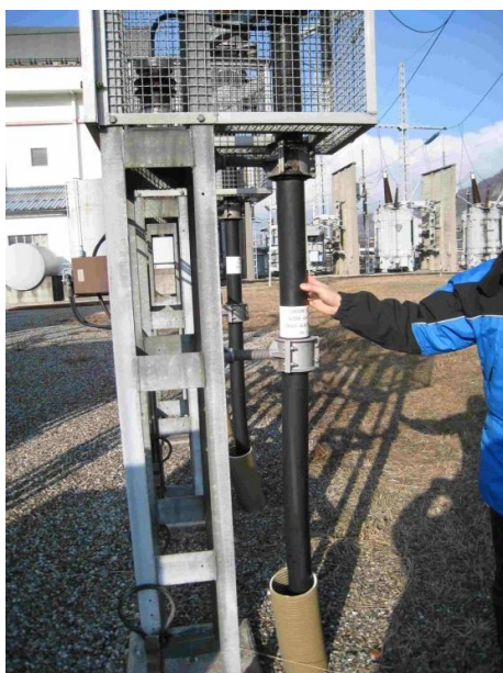
Figura A.192. Cable de 63 kV de 1 x 1.200 \text{mm}^2 .
