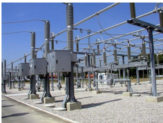
Figura A.145. Interruptor de SF6 de tanque vivo, monopolar, accionado por resorte y con cámara de autocompresión.
