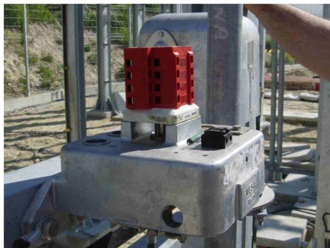
Figura A.160. Caja de contactos de un seccionador. Figura A.161. Seccionador de puesta a tierra. Fuente: Electrotaz.
