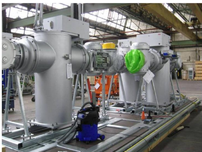
Figura A.213. Montaje al bastidor de SGI (subestación GIS integrada) Fuente: ABB.
