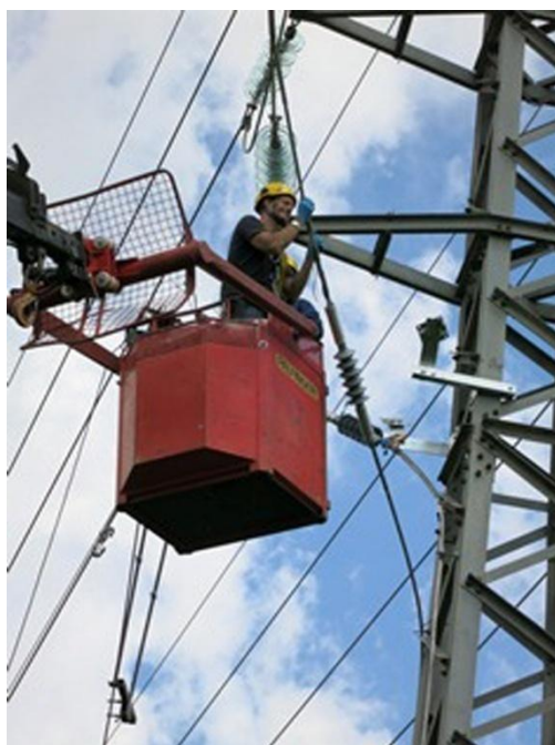
Figura A.256. Línea de MT con cable OPPC (conductor de fase – fibra óptica). Fuente: Prysmian.
