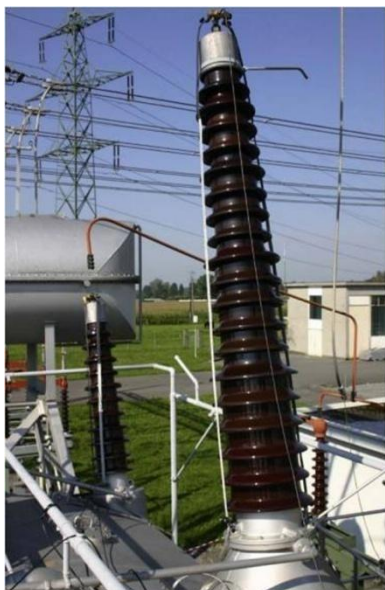
Figura A.250. Pruebas de diagnóstico del núcleo y devanados de un transformador. Fuente: Omicron.
