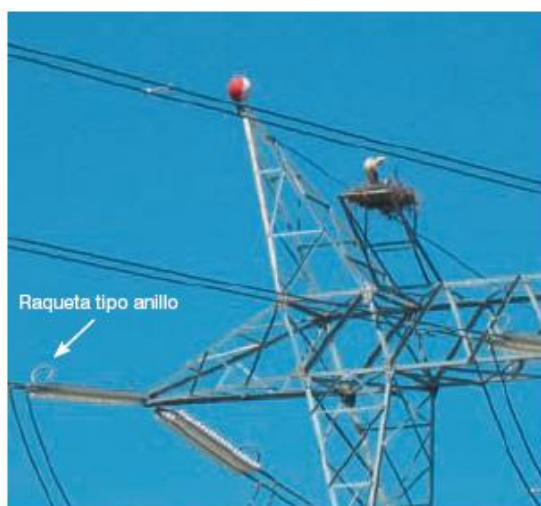
Figura A.170. Cadena de aisladores de amarre con raqueta de tipo anillo.
