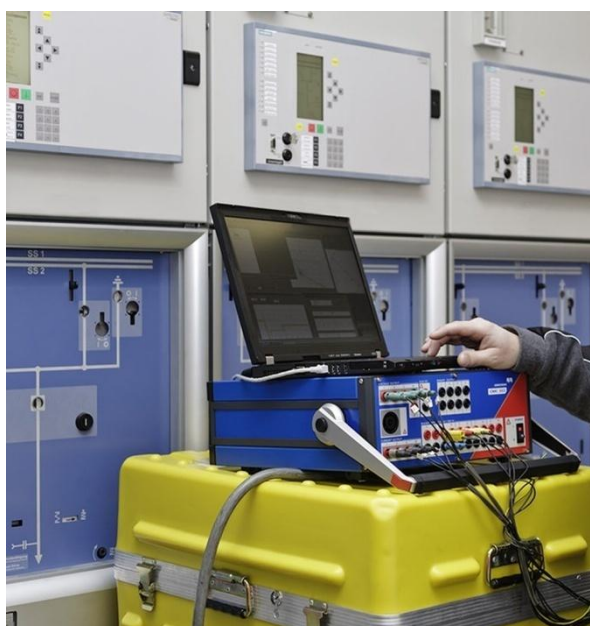
Figura A.127. Equipos para pruebas de protección trifásica y puesta en servicio de sistemas Scada. Fuente: Omicron.
