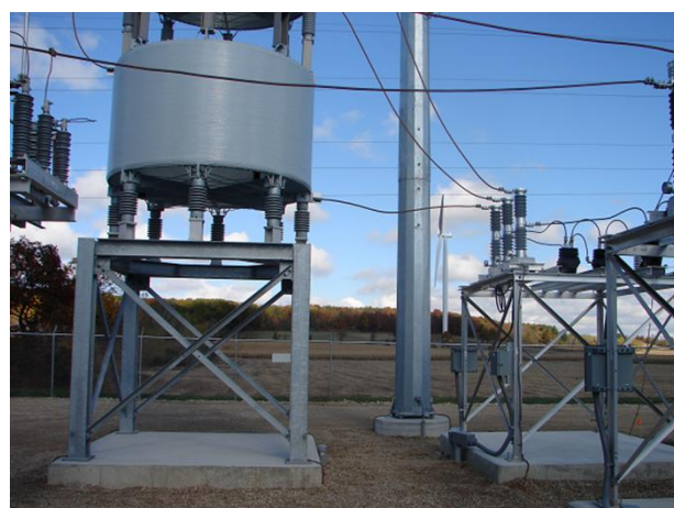
Figura A.146. Interruptor de SF6 protector de los capacitores. Fuente: Southern States.
