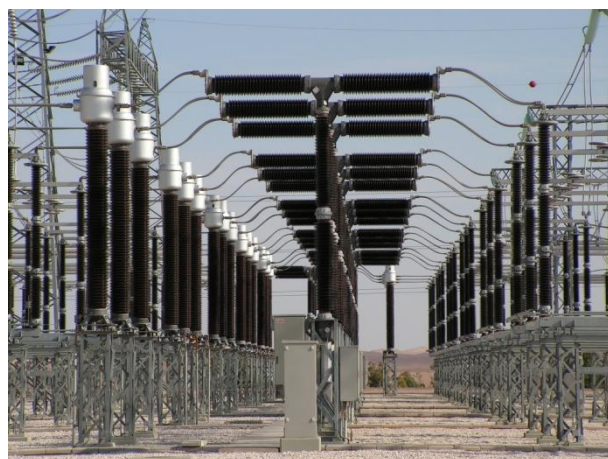
Figura A.144. Interruptores automáticos de SF6 de tanque vivo. Fuente: Arteche.
