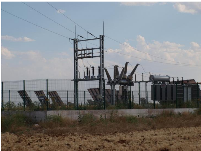
Figura A.135. Interruptores de tanque muerto.
