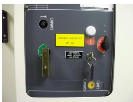
Figura A.41. Enclavamiento en interruptor automático abierto y bloqueado. Llave extraíble.
