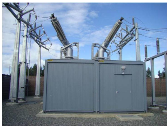
Figura A.216. SGI (subestación GIS integrada) conectada a la red. Fuente: ABB.
