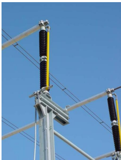
Figura A.160. Caja de contactos de un seccionador. Figura A.161. Seccionador de puesta a tierra. Fuente: Electrotaz.
