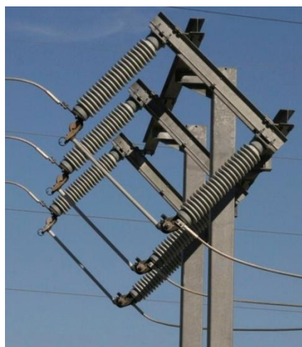
Figura A.166. Fusibles de potencia. Fuente: Southern States.
