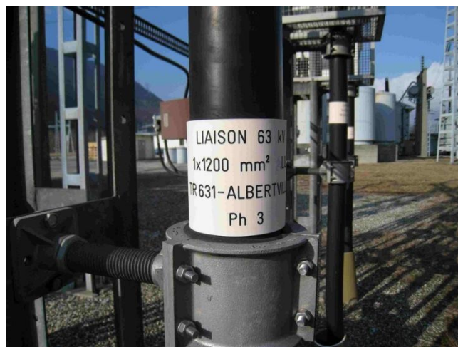
Figura A.192. Cable de 63 kV de 1 x 1.200 \text{mm}^2 .
