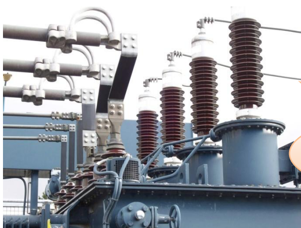
Figura A.3. Transformador de potencia 66/15/6 kV.
