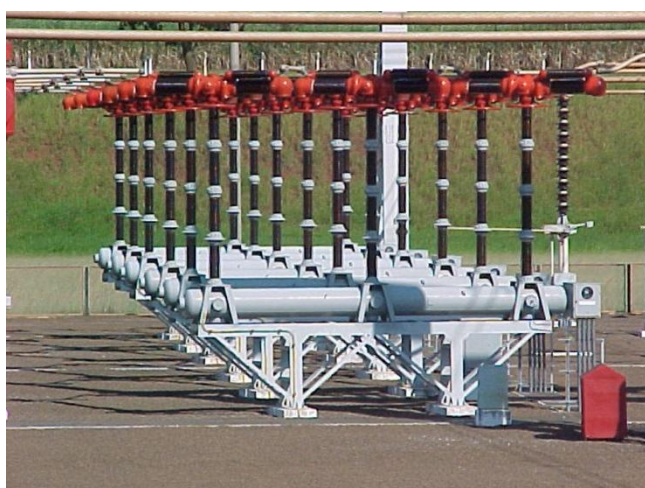
Figura A.141. Interruptor automático de aire comprimido. Fuente: Crenergia.
