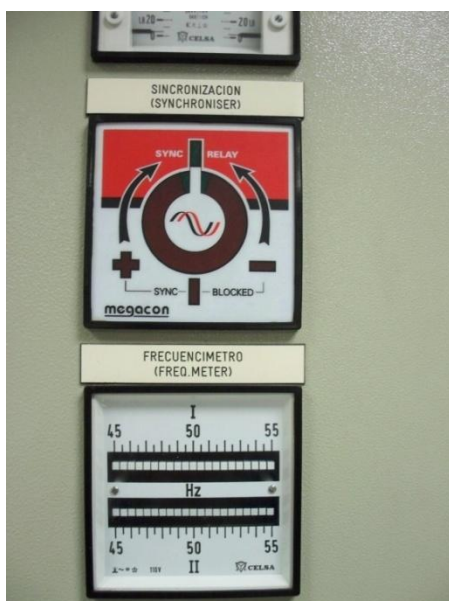
Figura A.8. Sincronoscopio.
