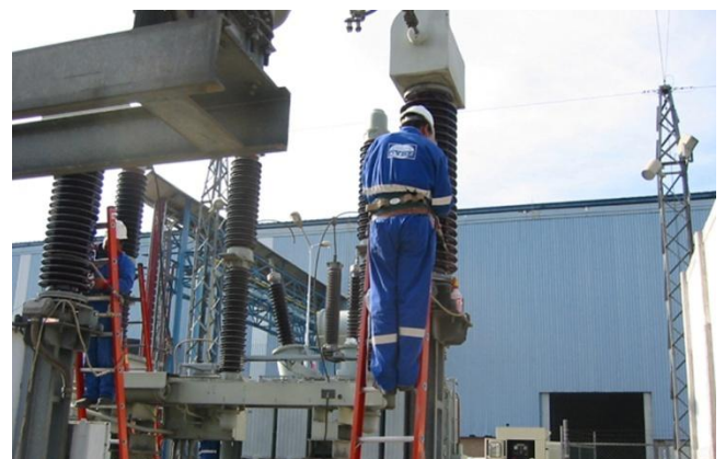
Figura A.249. Mantenimiento. Fuente: Syse.
