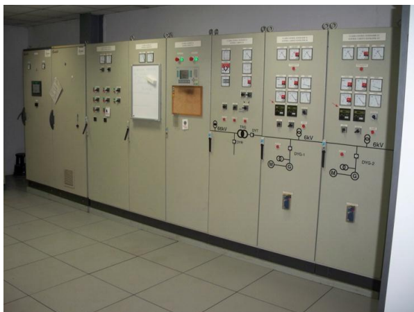
Figura A.10. Celdas de sincronoscopio y medidas.
