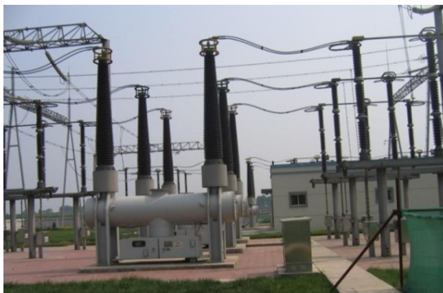
Figura A.147. Interruptor monopolar de tanque muerto.
