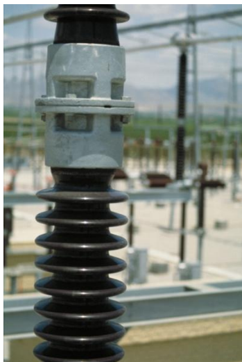
Figura A.168. Aislador de subestación.
