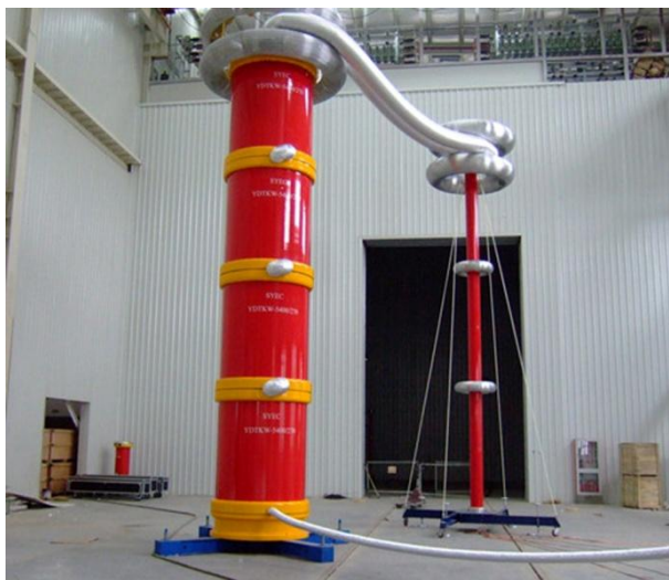
Figura A.255. Instalación para ensayos de equipos GIS. Fuente: Sieyuan.
