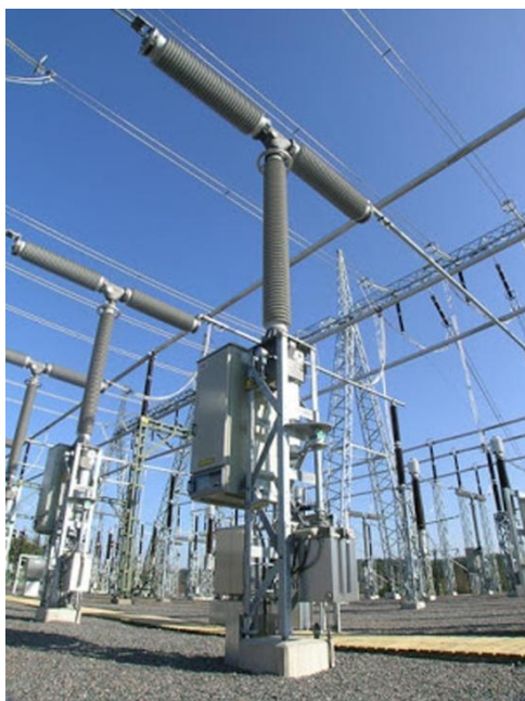
Figura A.136. Disyuntos seccionador.
