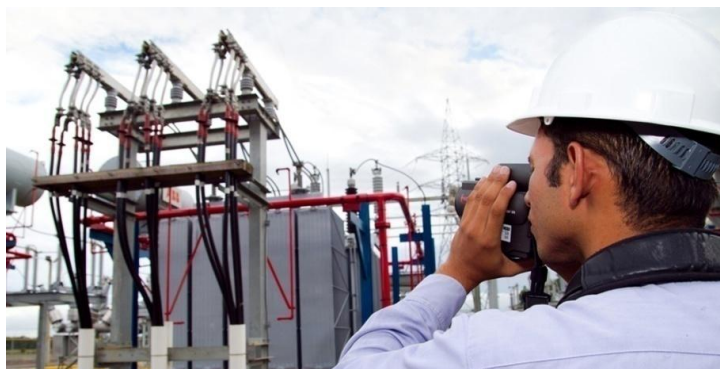
Figura A.251. Prueba termográfica. Fuente: Inproca.
