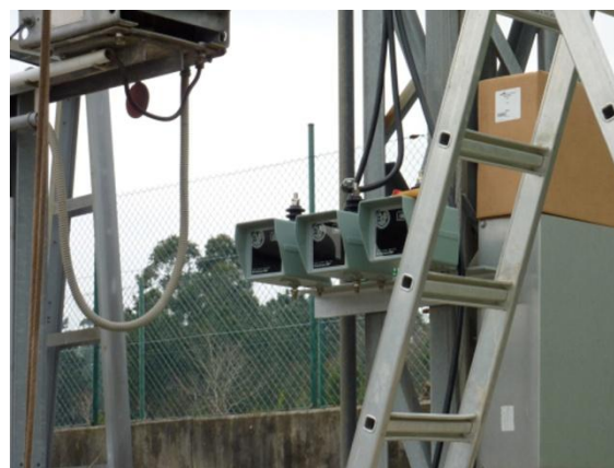
Figura A. 167. Contadores de corrientes de fuga y descargas de autoválvulas.
