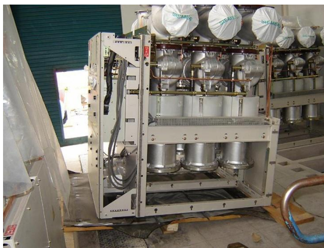
Figura A.195. Conjunto de interruptor de potencia en instalación GIS. Fuente:
