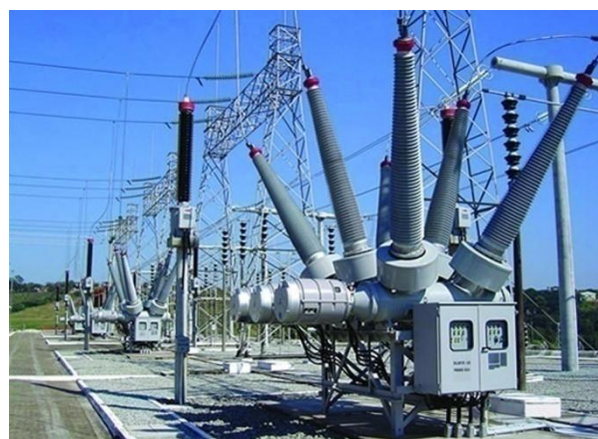
Figura A.148. Interruptor automático de tanque muerto. Fuente: ABB.
