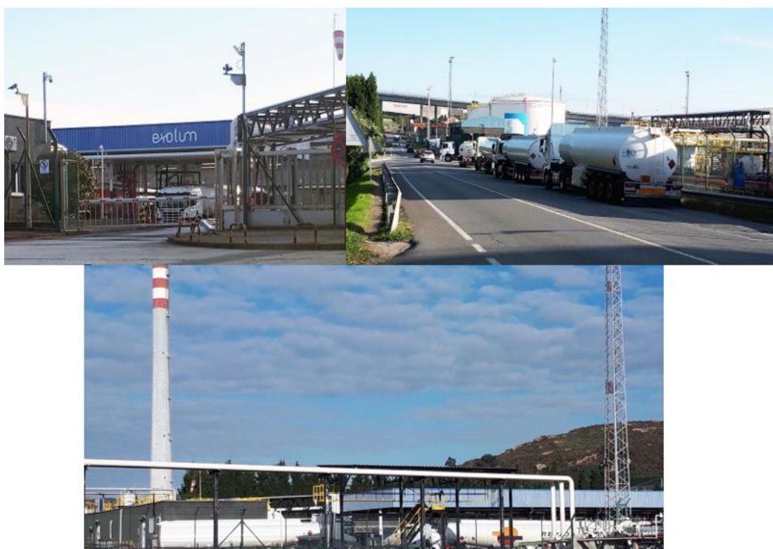
Figura 2.16. Industria de transporte y almacenamiento de combustible, hidrocarburos y productos petrolíferos de la empresa Exolum.
