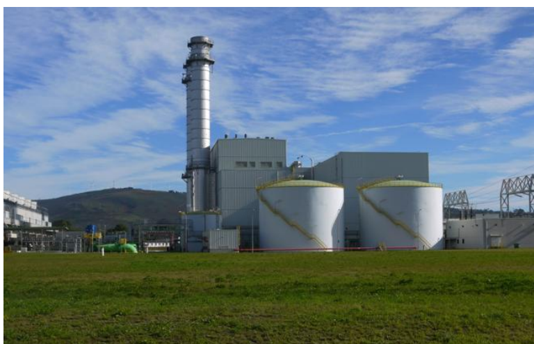
Figura 2.13. Central eléctrica de ciclo combinado de As Pontes.
