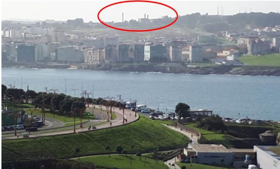
Figura 2.9. Vista de algunas chimeneas de la refinería, desde la Torre de Hércules de A Coruña.
