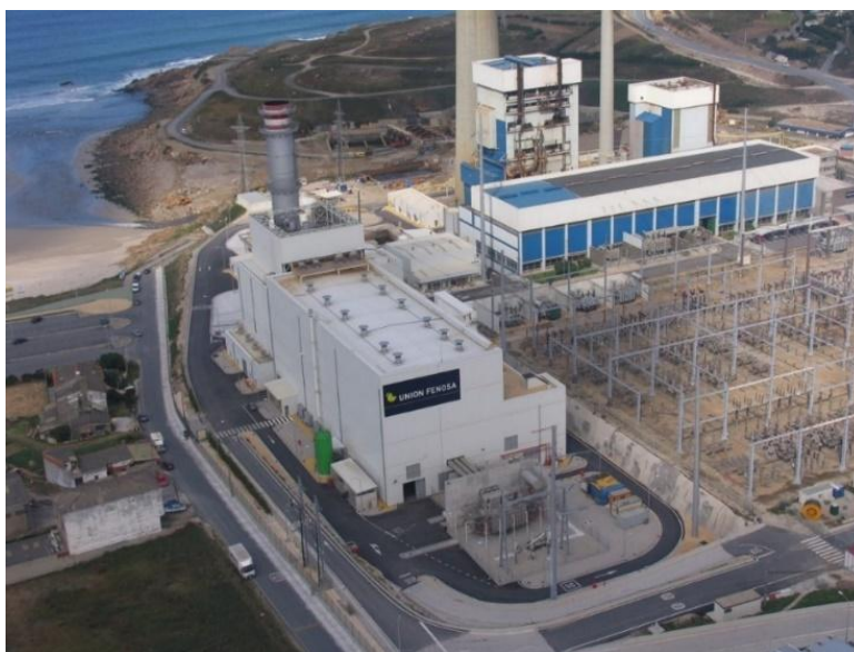
Figura 2.12. Central eléctrica de ciclo combinado de Sabón. Fuente: Horta Coslada
