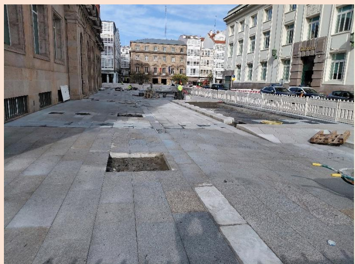
Figura 3.4. Construcción de un monumento al hormigón. Noviembre 2025
