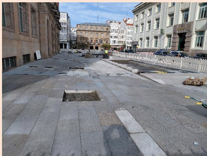
Figura 3.4. Construcción de un monumento al hormigón. Noviembre 2025
